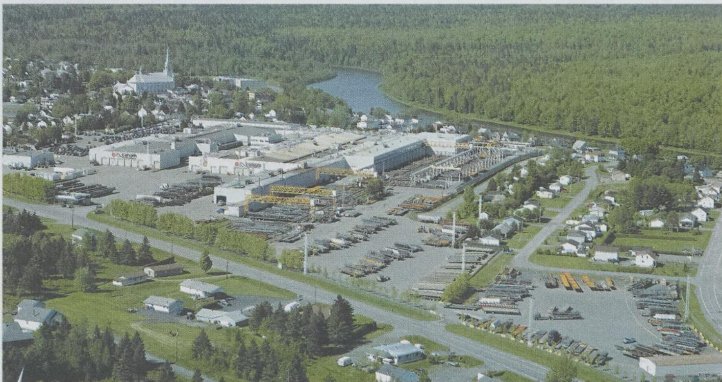
Photo aérienne récente de l'usine de Saint-Gédéon construite sur un terrain de 43 acres. Avec une capacité de levage de près de 80 tonnes, l'usine peut manœuvrer aisément les pièces d'envergure requises sur certains projets complexes.
