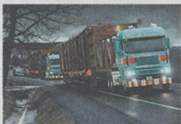
En 2005, transport des composantes pour la construction des passerelles dans le cadre du projet Rendez-Vous à la Rivière à Saint-Georges.
