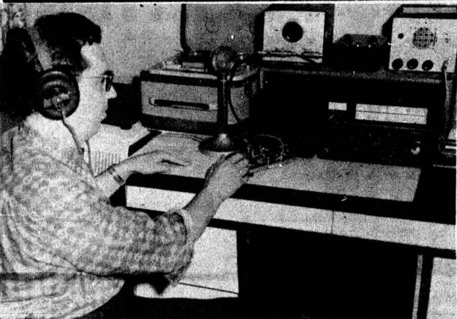
L'opérateur cherche à syntoniser un appel sur le récepteur. Quand il a capté le message, il le transcrit sur une machine à écrire le braille.
