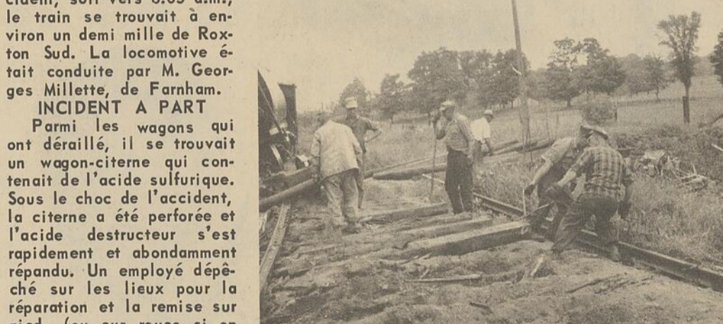
On voit sur cette photo les employés qui ne tardèrent pas à se mettre au travail pour refaire la voie ferrée endommagée à la suite de l'accident ferroviaire survenu à Roxton Sud.
