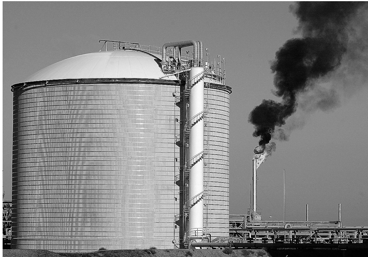
Un réservoir de pétrole dans une raffinerie au Venezuela.
