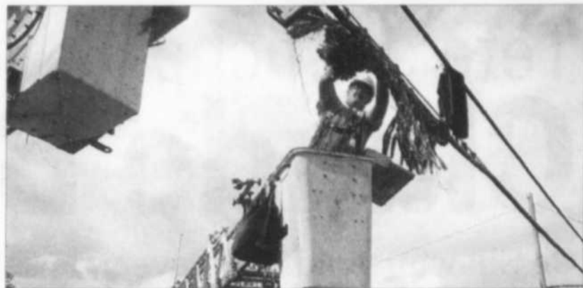
Guy Walsh, de Trois-Rivières, est épisseur pour la compagnie de télécommunications Expertech. Depuis octobre, il aide à rebâtir le réseau téléphonique dans un Mississippi dévasté par l'ouragan Katrina.
