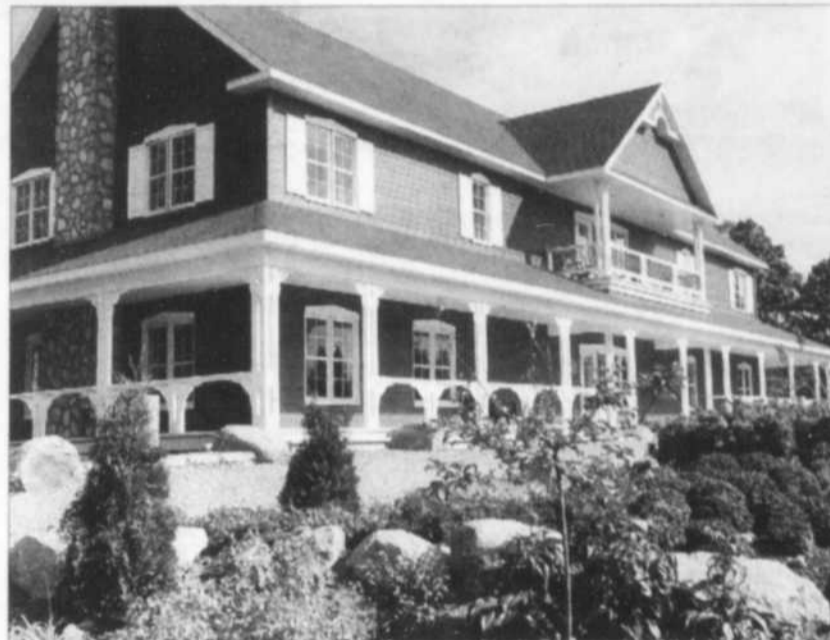
Depuis plusieurs années, le Baluchon éprouve de sérieux problèmes de traitement de ses eaux usées. Ses installations ne suffisent plus à la tâche.
