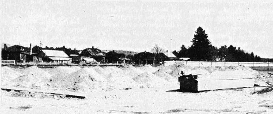
Les travaux sont en cours pour le centre des loisirs de Saint-Charles. Les fondations ont été réalisées et la structure devrait commencer à prendre forme cette semaine.
