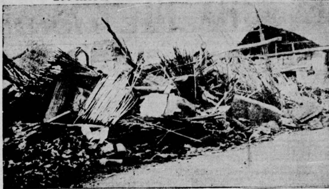
Voici ce qui reste de l'une des plus vastes résidences dans le district de Santa Ana, en Colombie, à la suite d'un tremblement de terre qui causa entre 200 et 300 morts, ensevelissant nombre de villages sous des tonnes de terre et de roc.
