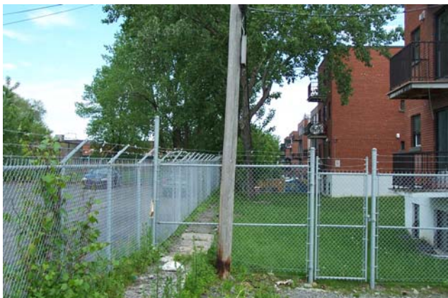
Clôtures de séparation entre les cours et la zone industrielle
