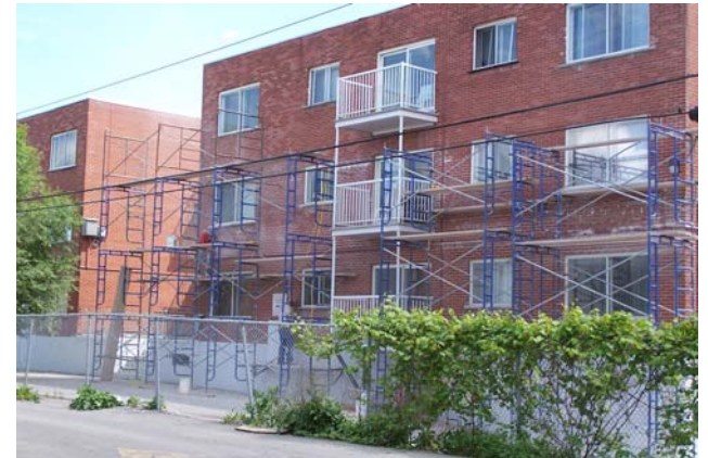
Façade nord d'un immeuble en cours de rénovation
