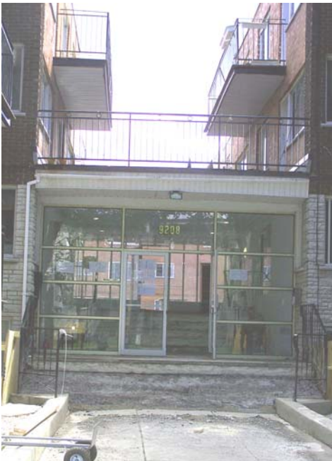
Entrée nord d'un immeuble d'habitations en cours de rénovation
