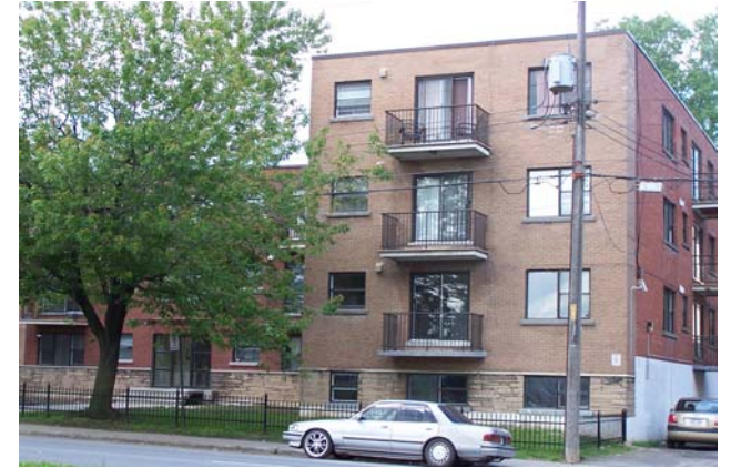
Immeuble d'habitations coin Airlie / 90 e Avenue
