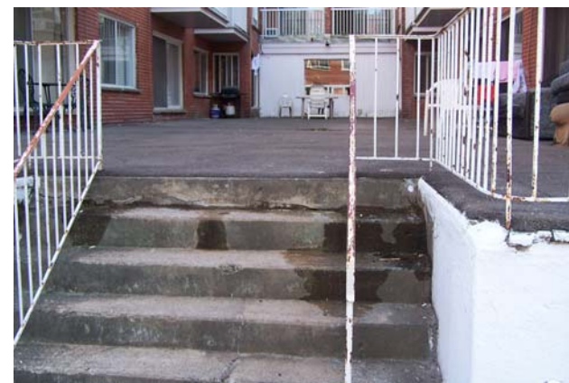
Entrée nord d'un immeuble d'habitations
