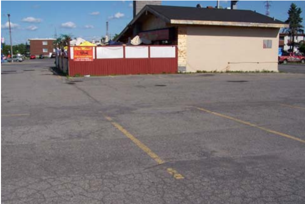
Vue ouest du restaurant
