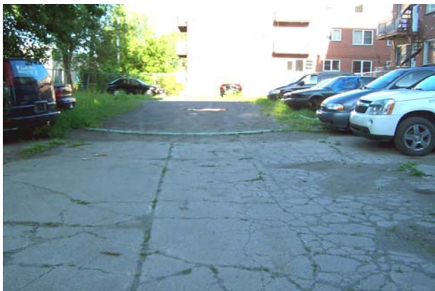
Ancienne piscine extérieure convertie en espace de stationnement
