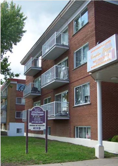
Immeuble d'habitations rénové
