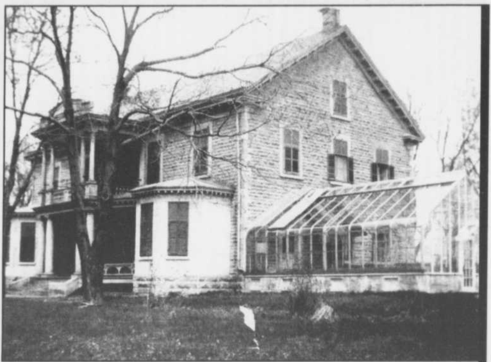
La Maison grise, dans l'est de la rue Saint-Louis, Terrebonne, photographiée vers 1929, résidence de la famille Alphonse Desjardins au moins jusqu'en 1931. À l'époque on pouvait admirer cette serre côté est, qu'on a fait disparaître lors de la construction des propriétés dans ce qu'il est convenu d'appeler «le rond-point Langlois», du nom du constructeur, Émile Langlois, président de l'ex-Canada Flushwood Door de la rue Théberge. (Photo de la famille Desjardins-Faribeu de Montréal, collection Aimé Despatis, Centre régional d'archives de Lanaudière)
