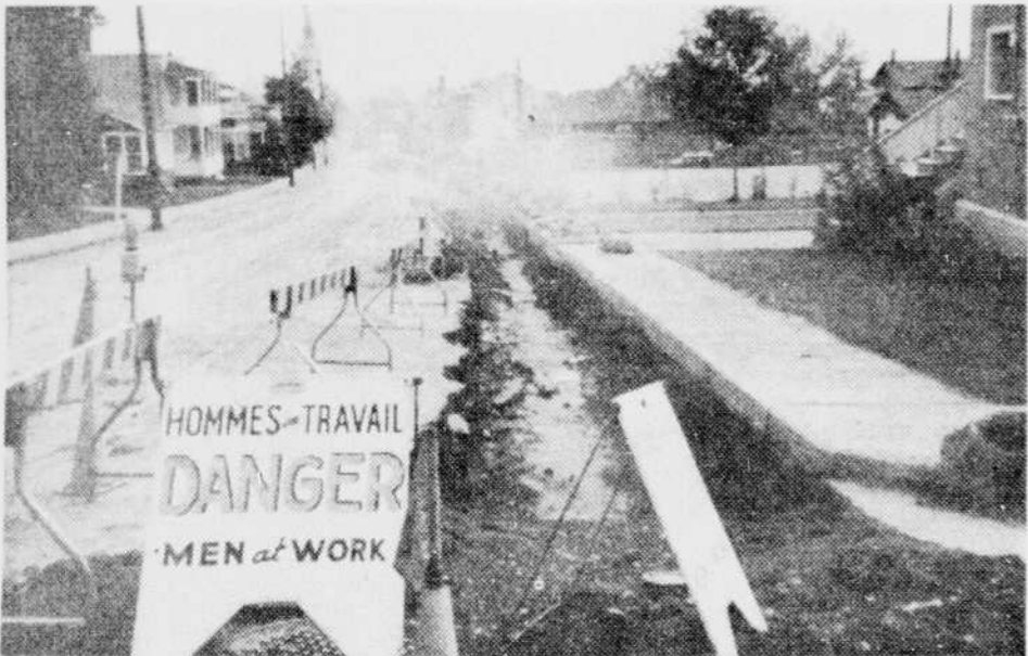
TUYAUX D'AQUEDUC — Des tuyaux d'aqueduc de deux pouces ont été remplacés par des tuyaux de six pouces sur la rue Hôtel de ville, à East Angus. On y installe également des bornes-fontaines en vue de faciliter le travail des sapeurs en cas d'incendie. Les travaux sont sous la direction du contre-maitre de la ville, M. Roger Thériault. (Photo La Tribune, par Mme G. Pomerleau)
