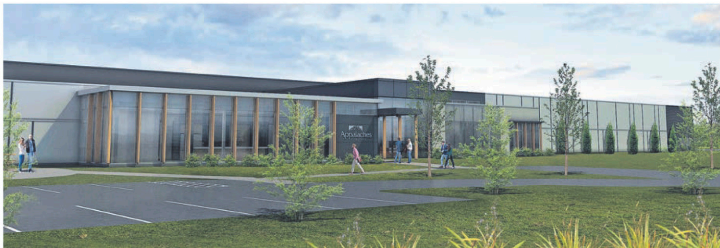
La Ville a notamment autorisé la construction de l'usine de produits sucrants Appalaches Nature sur la 9 e Rue Sud. (Photo gracieuseté)
