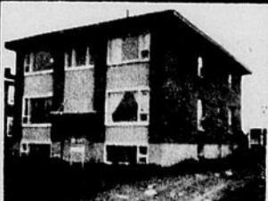
BLOC APPARTEMENTS 351 Doucet, Rimouski
