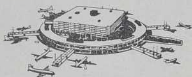
l'aérogare de Malton à l'aéroport international de Toronto
