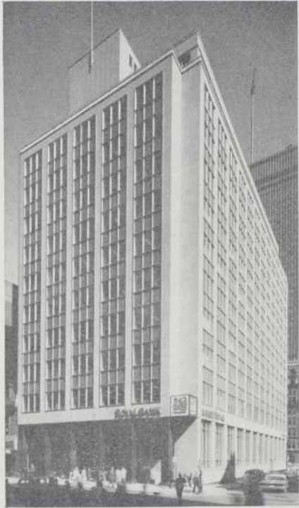
Immeuble de la Banque Royale Architectes: Mongenais, St-Jacques & Chicoine Installation par Kawneer Co. Canada Ltd.
