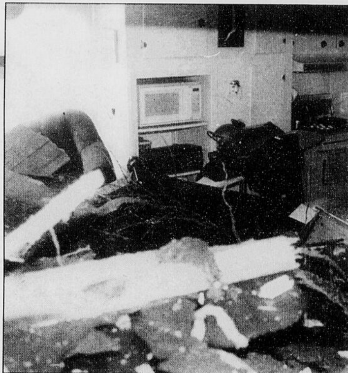
DOMMAGES - L'intérieur d'une maison a été sévèrement endommagé par le glissement de terrain. L'occupante des lieux était absente lors de l'événement.
