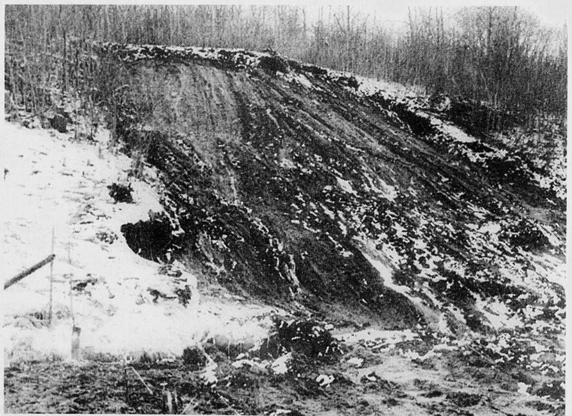
GLISSEMENT - Cet amas de terre donne une idée de la terre qui a glissé forçant l'évacuation de 53 personnes, hier, à Saint-Fulgence.
