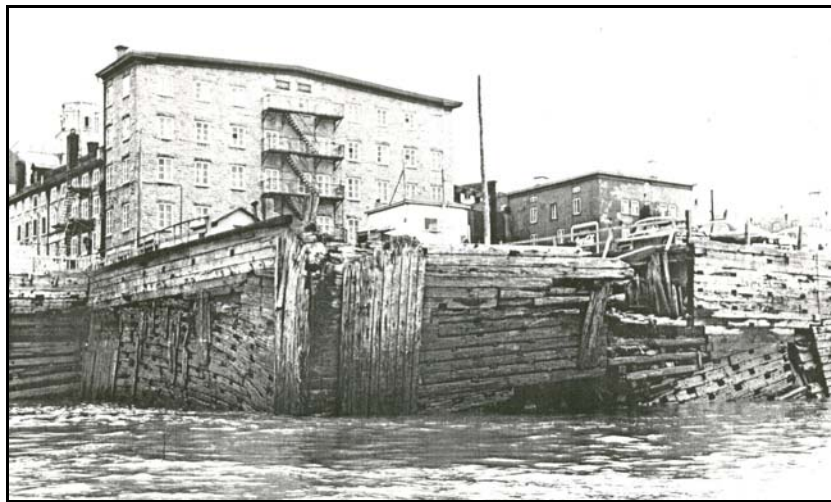
Figure 5. Vue d'une partie des quais près de la traverse à Québec en 1956. On aperçoit encore les parements percés de tirants Source: A.N.Q., A101/E3155, no. 3506
