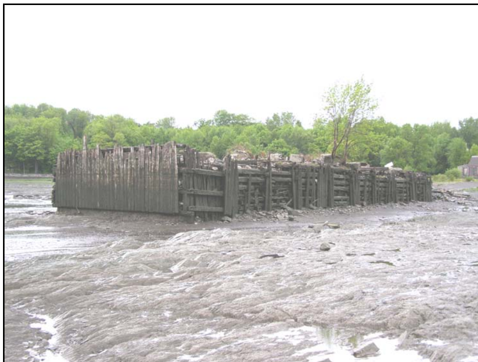
Figure 14. Ancien quai de la batellerie de Saint-Laurent, Île d'Orléans
