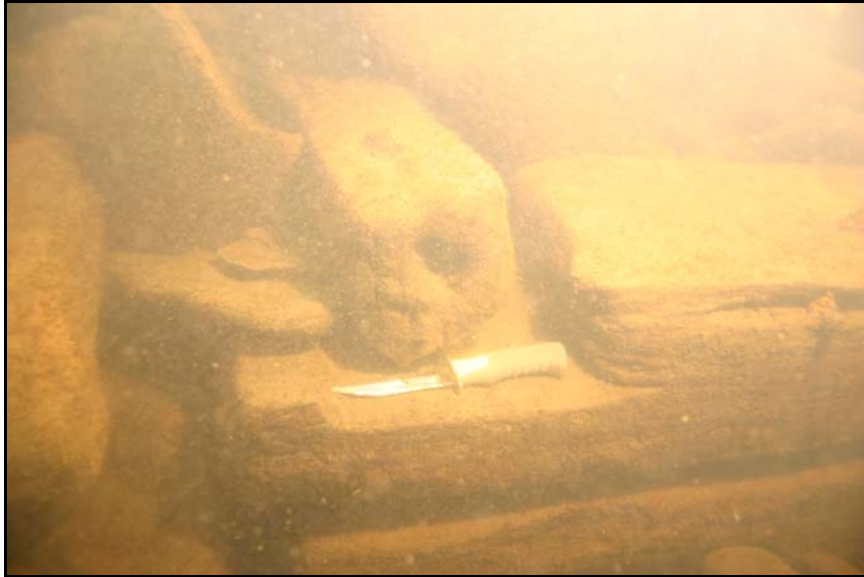
Figure 19. Vu du quai des Trois-Lacs. Cette photo sous-marine illustre le coin nord-est de la charpente submergée de l'ancien quai trouvé au lac Mégantic. On y reconnaît le mode de liaison par empatement. Photographie : Frédéric Simard
