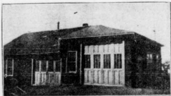
Voici la photo des ateliers de M. Florian Veilleux, un pionnier à se spécialiser dans la soudure dans la région de Sawyerville aux Frontières.
