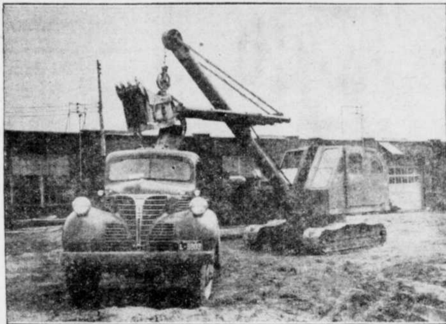
La petite mécanique d'une capacité de 50 de verge, sert à la construction dans la région. Le camion est préposé au transport.
