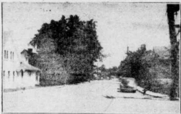
Une section de la rue Principale à Sawyerville.
