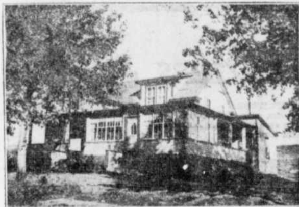
Ci-dessus la résidence qui renferme les bureaux de M. P. LABRECQUE
