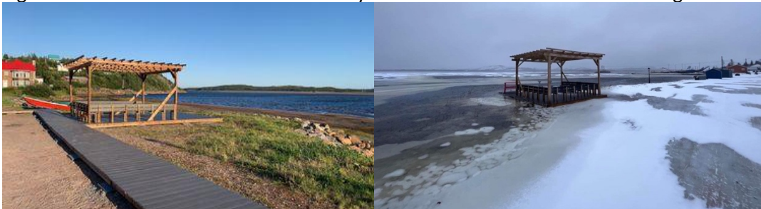
Figure 10 : Rivière avant la crue de 2022 ayant causé une inondation à Saint-Augustin
