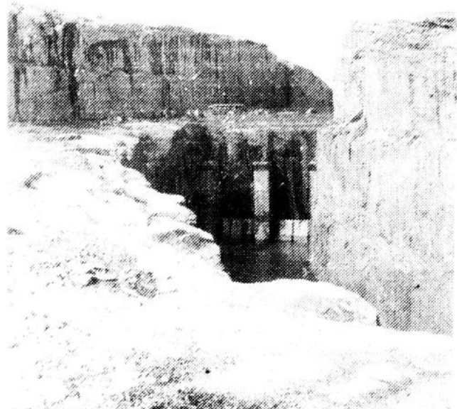
On aperçoit ici l'évacuateur des crues sous lequel est excavé la galerie de dérivation.
