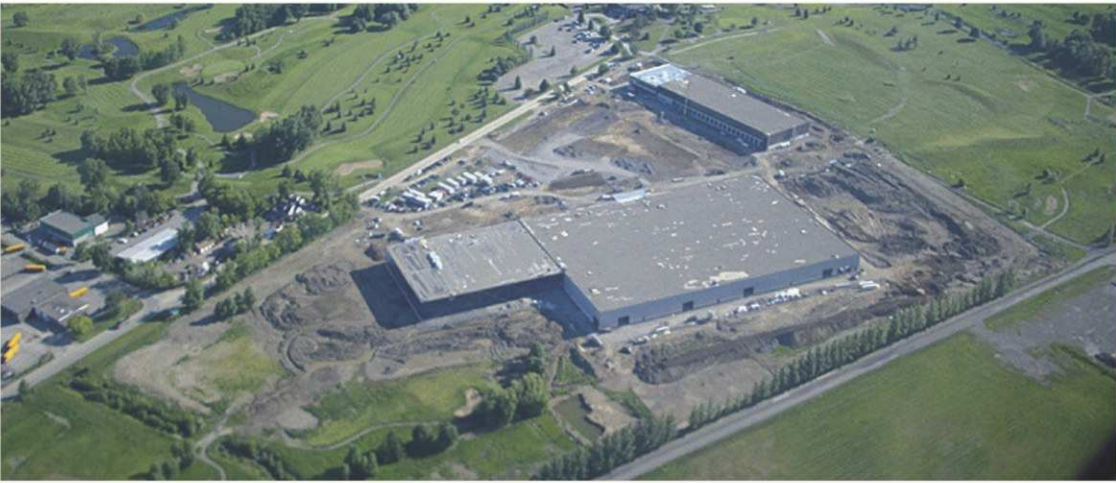
C'est Toitures P.L.M. qui a fait la toiture pour le projet Cargo Village Dorval en 2008.
