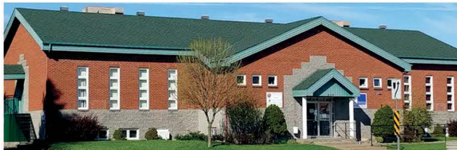
Parmi les travaux prévus à Sainte-Julie, il y a l'agrandissement des ateliers municipaux et la mise à niveau du centre communautaire du 550, boul. Saint-Joseph, récemment acheté par la Ville.
