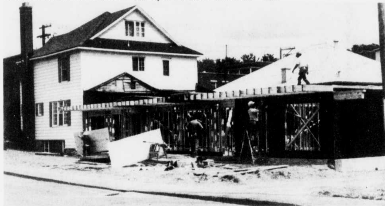
La construction de huit logements pour retraités devrait être terminée en octobre, afin de
