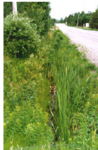
Photographie no 4 : La protection des lacs et des cours d'eau naturels commence loin en amont dans le bassin versant. Les fossés routiers constituent certainement l'un des éléments importants de la problématique, mais il en va de même de nos attitudes et de nos attentes en matière de drainage routier. Il faut à tout prix changer notre conception d'un fossé routier "propre" et s'habituer à y voir une végétation luxuriante. (Photo: RAPPEL, 97-07-07)
