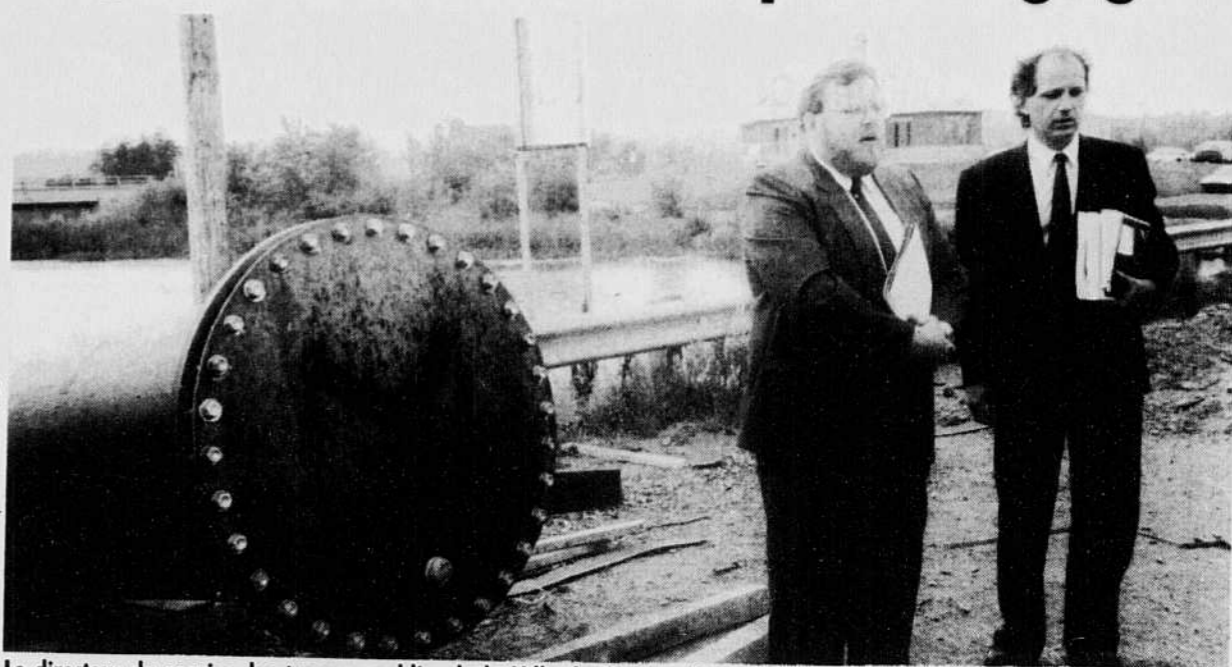
Le directeur du service des travaux publics de la Ville de Magog, M. Michel Turcotte, et un représentant du groupe de génie-conseil Teknika, M. Bertrand Côté, expliquent les étapes de la mise en place de la conduite qui alimentera le réseau d'aqueduc municipal.
