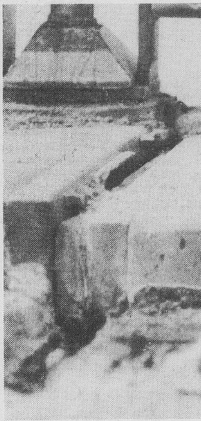
Dans la photo, on voit la différence qui existe désormais entre deux sections du tablier du pont Champlain.
