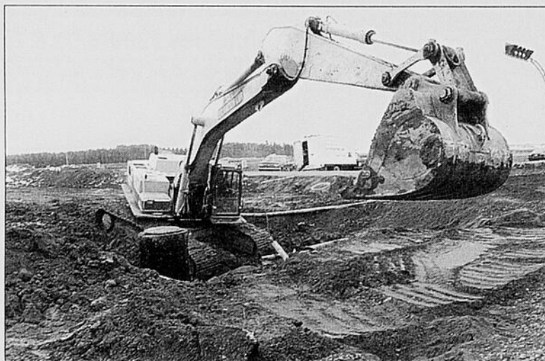
BÂTIMENT - D'ici quelques jours, les travaux de construction du bâtiment débiteront sur le chantier.
