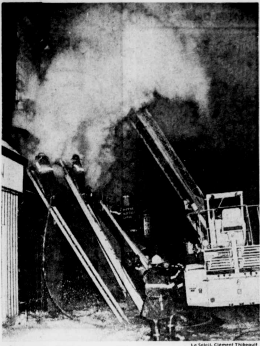
C'est dans le sous-sol de cette maison à côté de la taverne "Quartier Latin" que le feu a commencé ce matin, sur la rue Saint-Jean à l'angle de la rue Collin, dans le Vieux-Québec.
