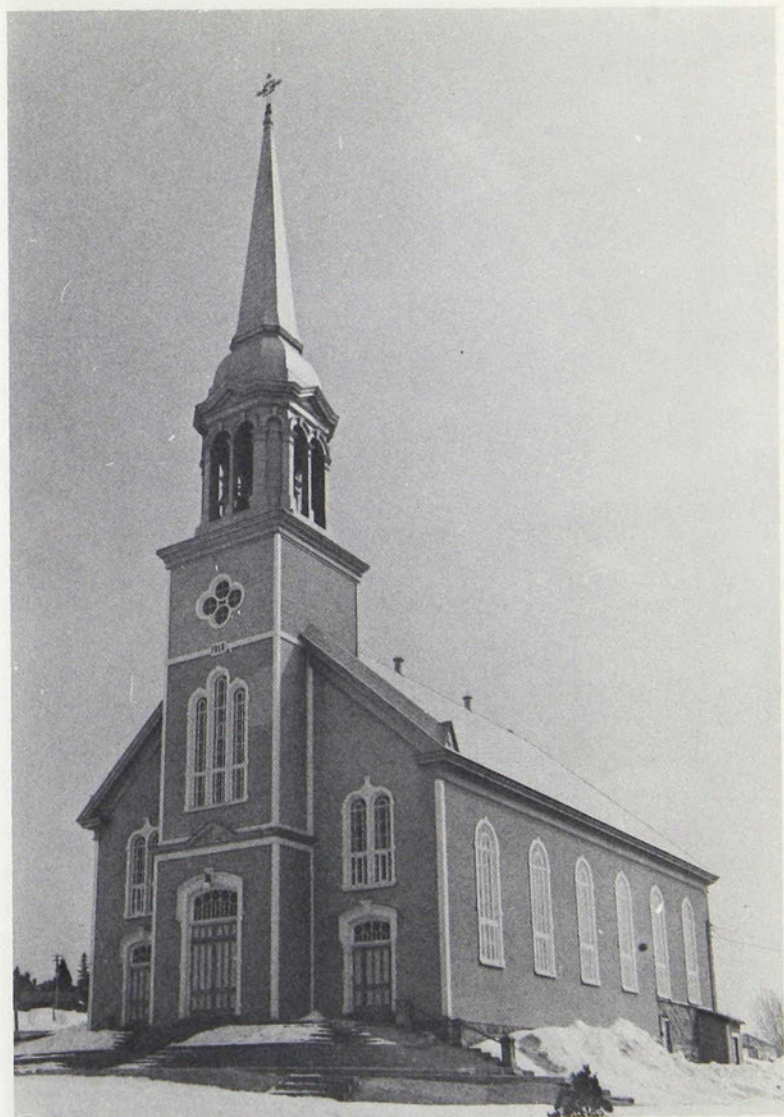
7. Grandes-Bergeronnes. Façade. Jos.-P. Ouellet, 1912.
