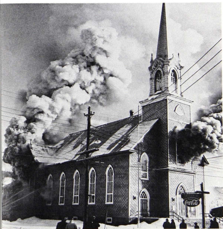
Saint-Urbain. Incendie de l'église construite en 1926 par Jos.-P. Ouellet.
