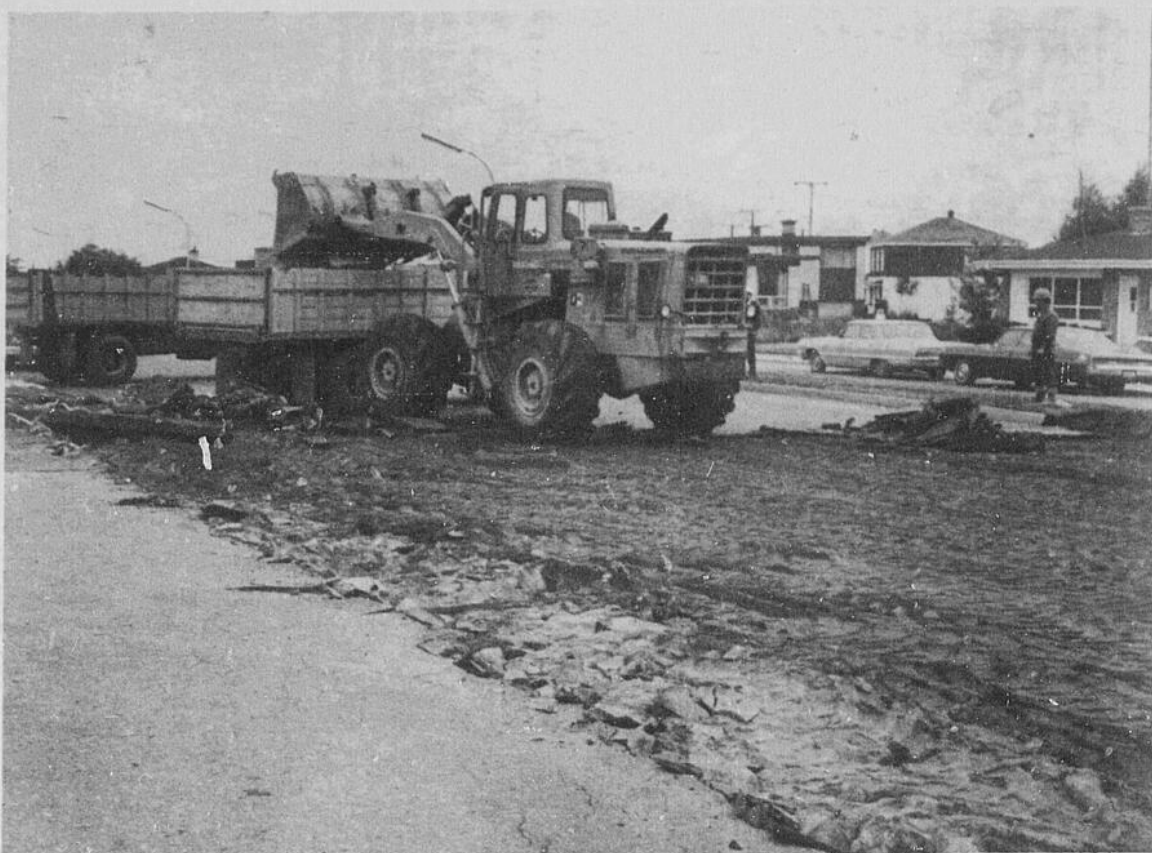
Le Boulevard Auger, du Boulevard Potvin, jusqu'au ruisseau Rouge, portera d'ici trois semaines une toilette toute neuve. Présentement, on enlève l'asphalte pour ensuite mettre du concassé qui servira à niveler le profil. On ajoute également un drainage du côté sud du Boulevard.
