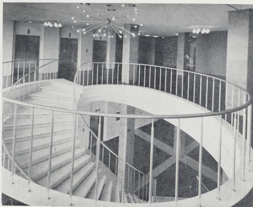
Le puits d'escalier vu du premier étage.
