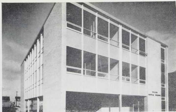
Immeuble Médical Wilson, rue Bathurst et avenue Wilson, Toronto. Architectes: W. J. Campbell. Entrepreneurs: Golmar Investments Ltd.
