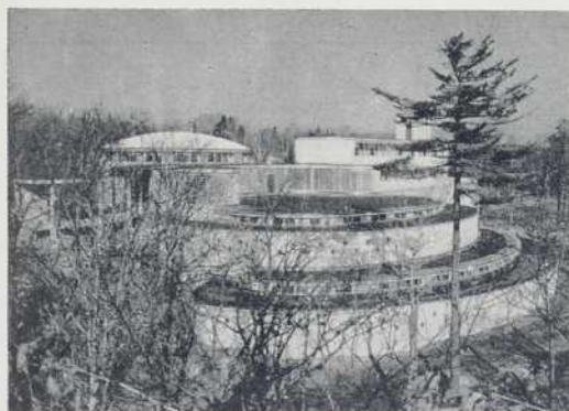
Ci-haut, vue semi-plongeante de l'ensemble donnant une idée du coup d'œil offert durant la traversée du pont de Québec.
