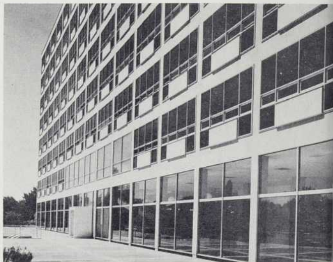
Détail du mur-écran.
