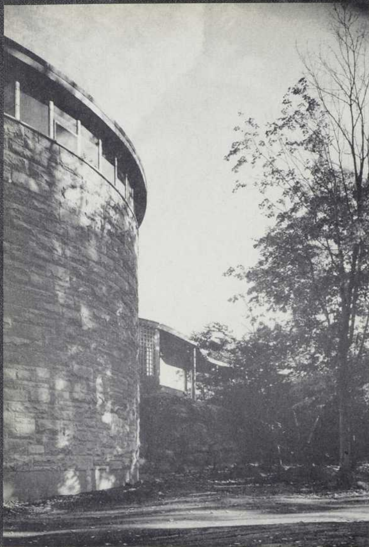
Une partie de la tour abritant l'auditorium et la bibliothèque-salle d'expo- sition.
