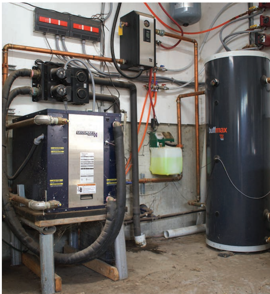
Des tuyaux remplis de glycol ont été insérés dans le béton du plancher aux endroits stratégiques de l'étable : l'allée de la raclette, l'aire d'attente du robot et le robot lui-même. Le glycol est maintenu à une température entre cinq et dix degrés grâce à un réseau de 4200 pieds de tuyaux enfouis dans le champ derrière l'étable.
