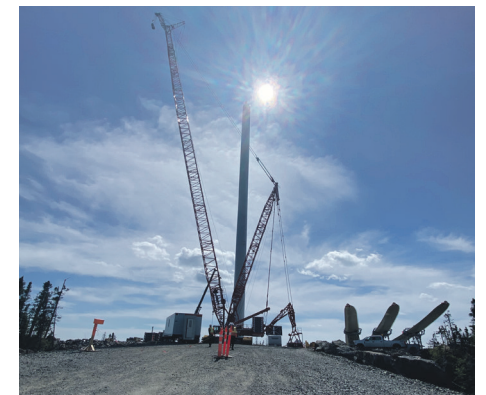
Le montage de 31 éoliennes a été réalisé et les dernières devraient être terminées à la fin du mois de mars. Photo courtoisie
