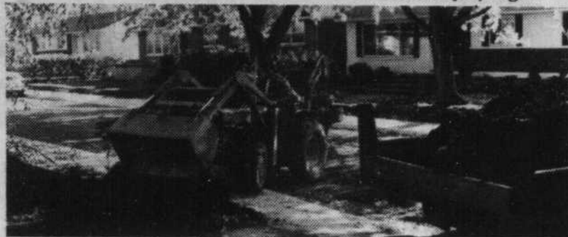
Non seulement l'asphalte est refait tout au long de la rue Labonté mais les correctifs paysagers sont aussi en voie d'être entièrement complétés.
