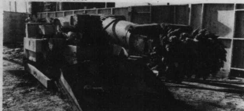
Intercepteur centre: les chantiers pour le creusage du tunnel entre les puits Roland-Therrien et De Lyon vont bon train. Chacun de ces puits accueillera une machine à forer (ou foreuse) qui permettra l'accélération des travaux tout en réduisant au minimum les inconvénients du dynamitage. Celle qu'on aperçoit ici vient d'arriver (22 octobre) au puits d'accès Roland-Therrien.
