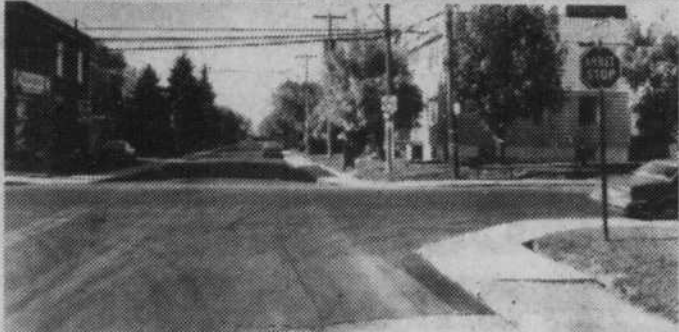
Angle Saint-Alexandre et Sainte-Catherine: on aperçoit ici la jonction du nouvel asphalte (foncé) et de l'ancien (pâle).
