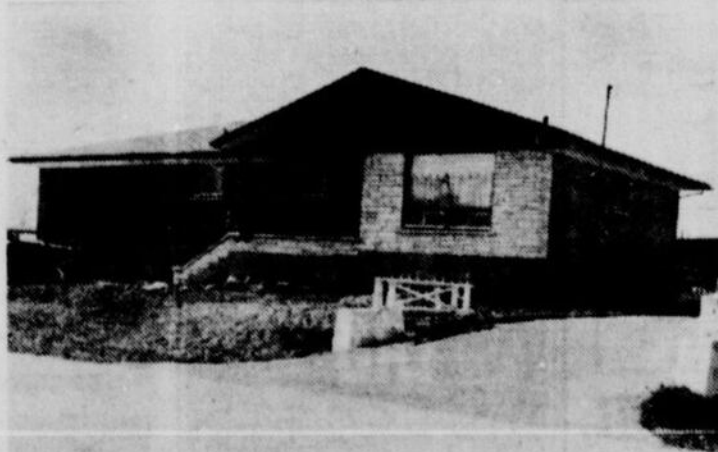
Cette coquette maison, Gilles Jean l'avait construite lui-même.
