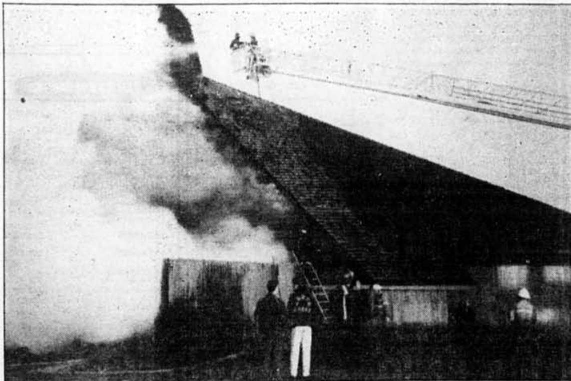
Des dommages importants ont été causés à l'église St. Thomas Becket, rue Pascal à Pierrefonds dans la nuit d'hier. photo LA PRESSE
