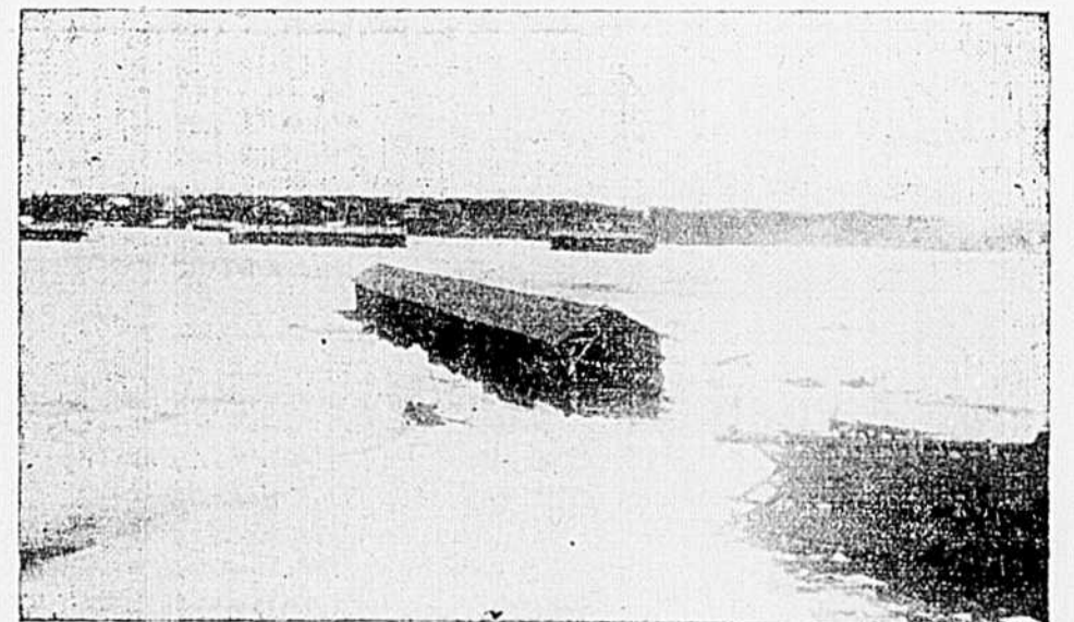
LA DEBACLE: On voit ici les parties de l'ancien pont flottant sur la rivière traînées par les glaces qui l'ont détruit le 26 avril 1942.
