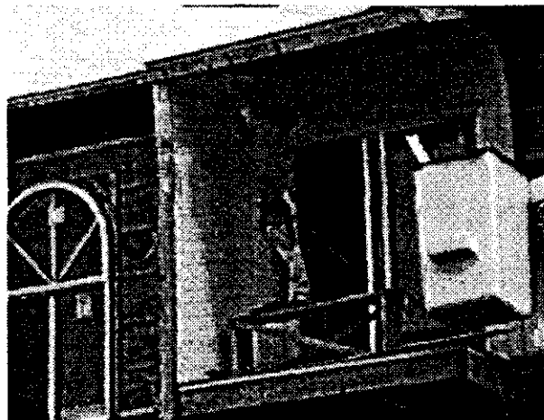
Figure 115 Utilisation d'un banc comme échafaudage sur le balcon du 2e étage.
