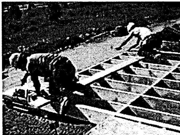
Figure 11 Clouage du madrier d'extrémité du balcon.
