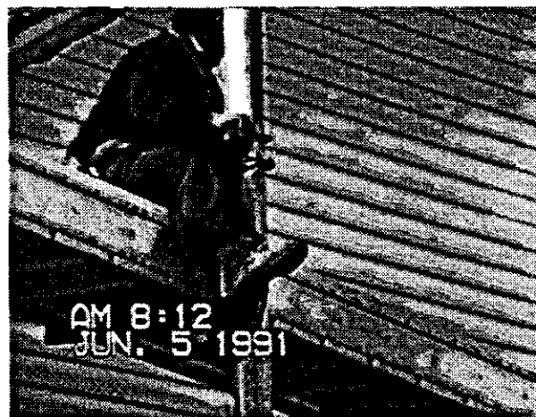
Figure 97 Descente du "Pump Jack" en actionnant la manivelle de chaque cric et en relâchant le frein avec la jambe.
