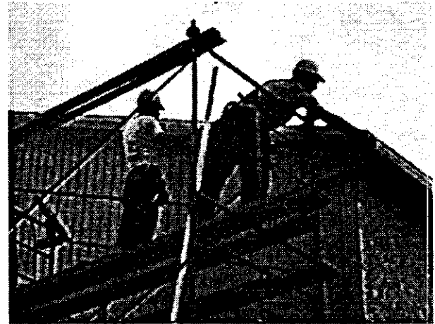
Figure 101 Travaux de soffite sur échafaudage roulant.
