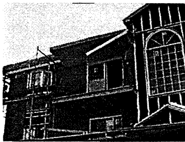
Figure 117 Recouvrement de la frise du toit surplombant le balcon du 2e étage.
