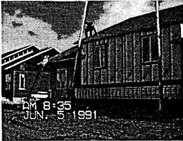
Figure 98 Déplacement d'une patte de "Pump Jack". Les travailleurs ont terminé le travail sur le côté de la maison (Figure 94) et démontent maintenant l'échafaudage.
