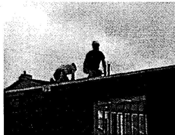
Figure 16 Clouage des panneaux de 4' x 8'.
