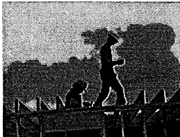
Figure 19 Déplacement sur les solives.
