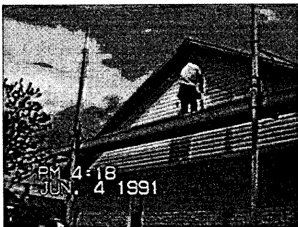
Figure 94 Utilisation d'un "Pump Jack" pour des travaux de soffite. Noter les amarrages au niveau du toit.
