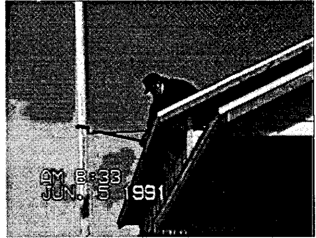
Figure 99 Installation de l'ancrage au niveau du toit.
