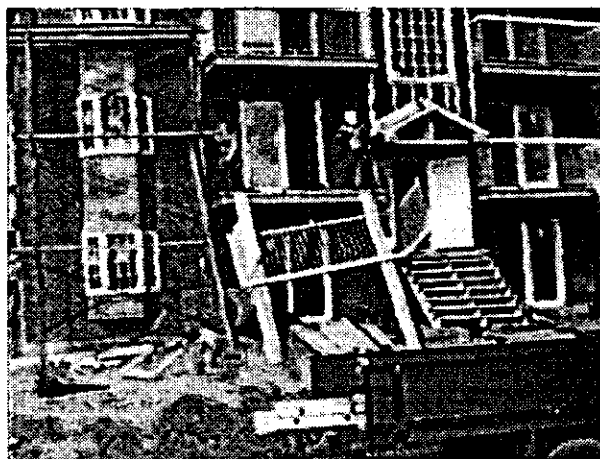
Figure 28 Glissement de la balustrade d'un balcon sur des madriers.
