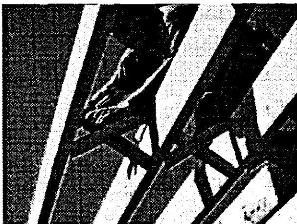
Figure 13 Installation des croix de Saint-André par le haut.
