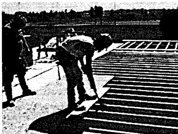
Figure 15 Installation en place des panneaux de 4' x 8'.
