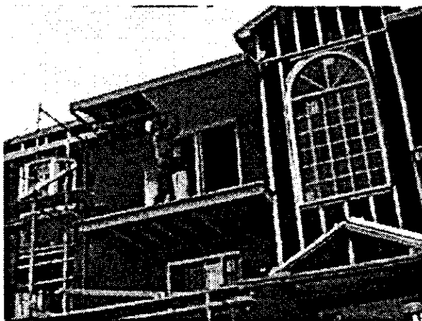
Figure 116 Recouvrement du dessous du toit surplombant le balcon du 2e étage.
