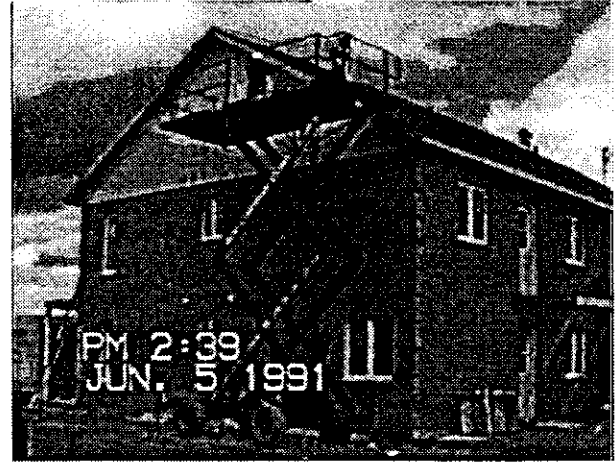
Figure 113 Recouvrement de la frise et du soffite à l'aide d'une plate-forme élévatrice.
