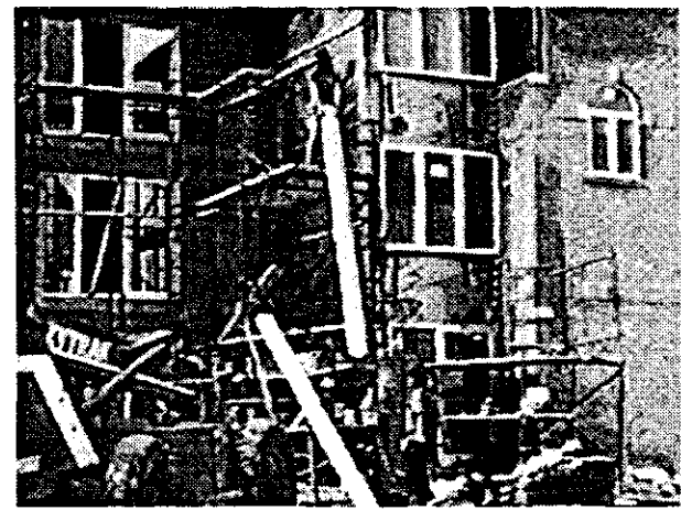
Figure 111 Travaux d'aménagement d'un plancher de travail au-dessus d'un échafaudage où travaille un maçon (non visible).
