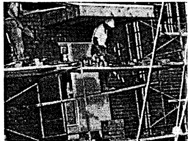
Figure 73 Utilisation des échelons pour ajuster le plancher de travail, ici en pente. Noter l'absence de croisillons du côté extérieur de l'échafaudage.
