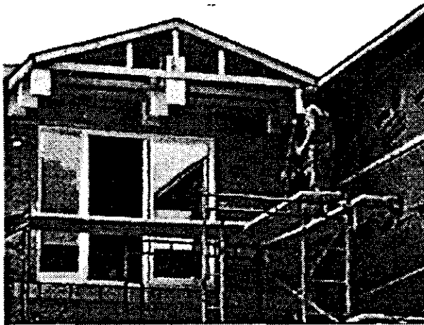
Figure 110 Aménagement d'un plancher de travail à partir d'un échafaudage de maçon.
