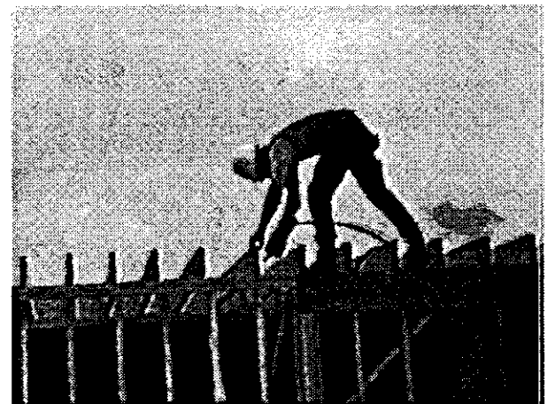
Figure 8 Clouage des solives sur le dessus d'un mur porteur à l'aide d'une cloueuse pneumatique.
