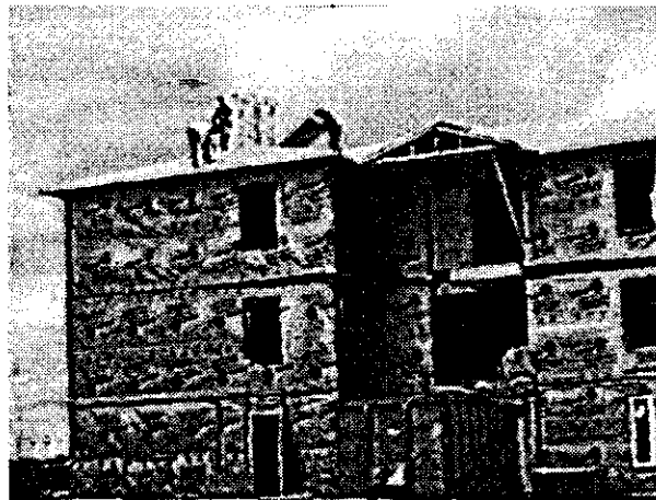
Figure 55 Installation et clouage des panneaux de 4' x 8' sur le toit à l'aide d'une cloueuse. Noter que les travailleurs ne sont pas attachés.
