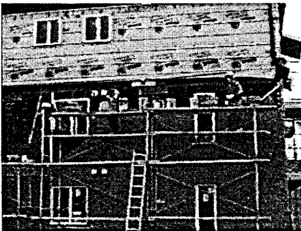
Figure 72 Échafaudage sans console (cadres de 5'). Les échelons sont utilisés pour supporter le plancher de travail. Noter l'absence de croisillons du côté extérieur de l'échafaudage.
