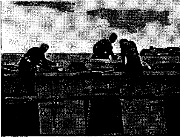
Figure 60 Échafaudages à consoles suspendues pour les travaux en bordure du toit.
