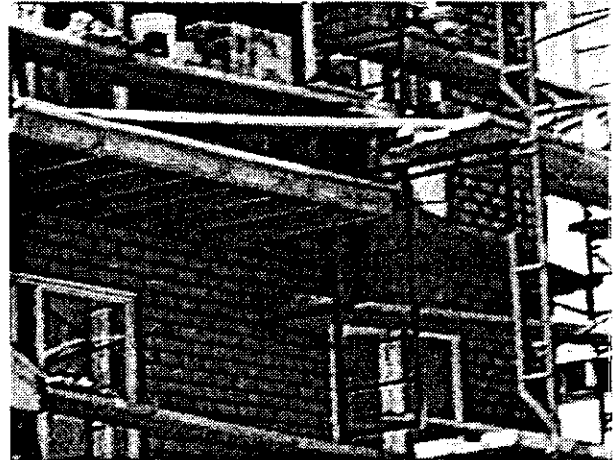
Figure 71 Échafaudage avec console fixe. Noter l'absence de croisillons du côté intérieur de l'échafaudage.
