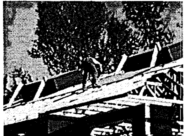
Figure 52 Lots de panneaux 4' x 8' installés sur le toit.
