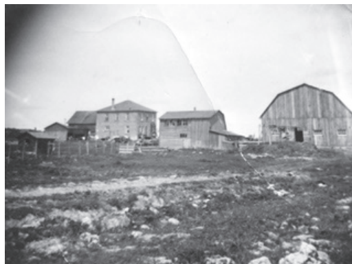
Vue arrière de la ferme
