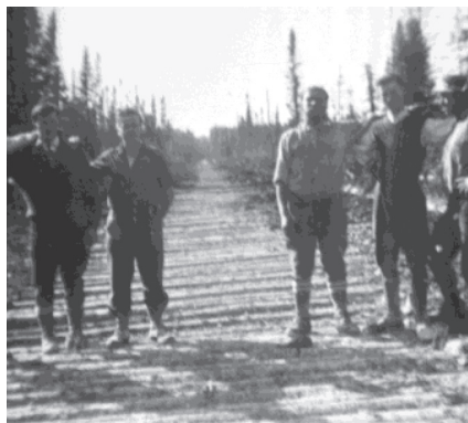
Du pontage dans un des chemins de Bellecombe
