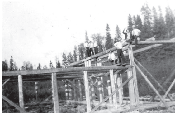
La construction du moulin à scie commence.
