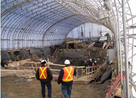
Aménagement du seuil au PK 207 par une entreprise de Chibougamau : « Les équipements J.V.C. inc. »
