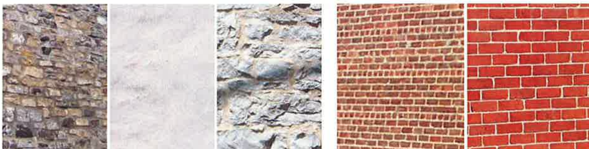
Maçonnerie de pierres
