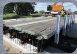
BETON poutres d'acier
