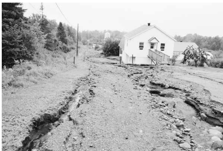
Les plus lourds dommages ont été signalés dans le rang Saint-Antoine-Nord, à Baie-Saint-Paul.
