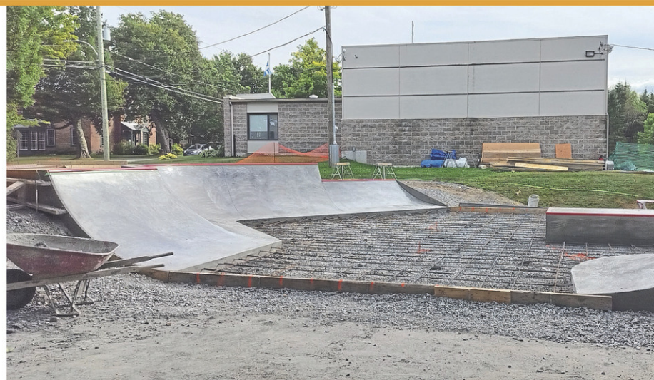
Les travaux sont déjà bien entamés à Inverness. (Photo gracieuseté)
