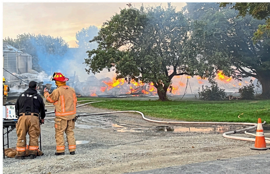
À l'arrivée des pompiers, le bâtiment s'était déjà effondré. (Photo www.lanouvelle.net)
