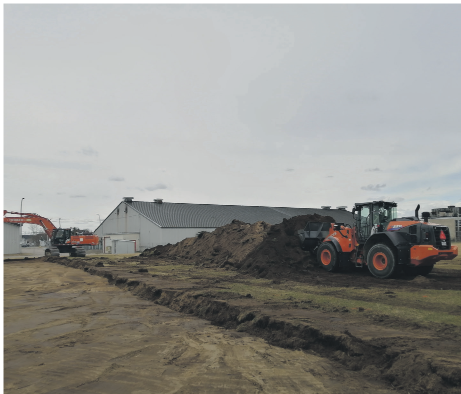
Les travaux d'excavation pour le nouvel aréna de Sept-Îles ont commencé le 12 mai. Photo Vincent Rioux-Berrouard
