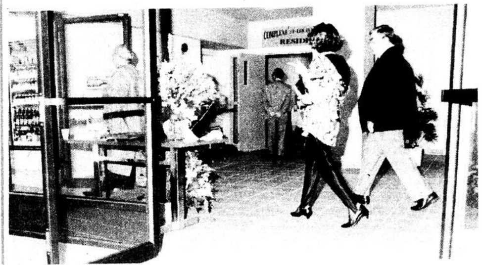
L'entrée principale a été modifiée afin de donner au hall d'entrée du Complexe une accessibilité au dépanneur et au Centre Travail Québec. L'entrée a également été adaptée pour les personnes en fauteuil roulant.
