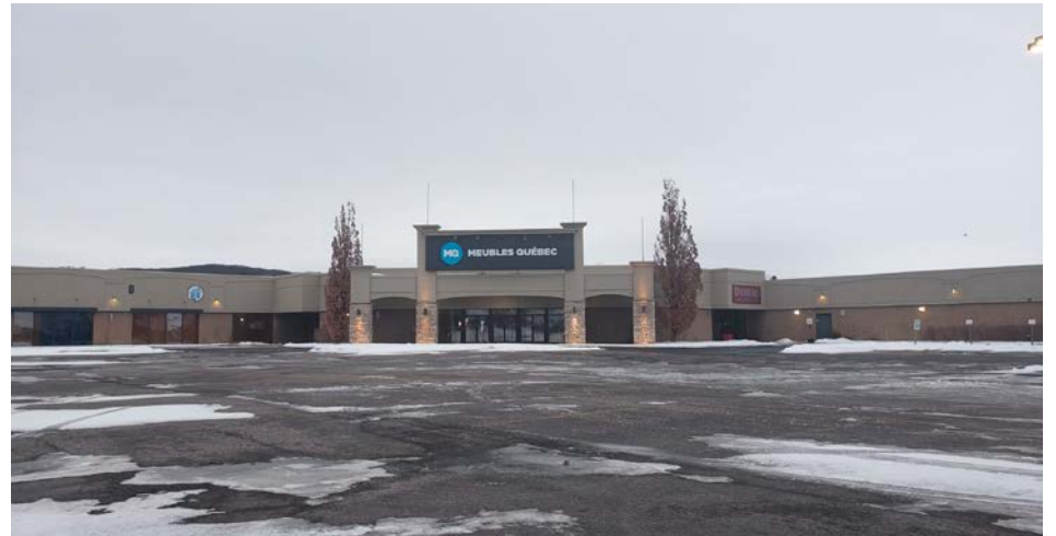
La démolition extérieure de l'ancien magasin Meubles Éthier devrait commencer sous peu. (Photo : Alexandra Vieille)
