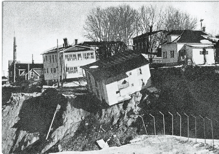
Quatre maisons glissèrent dans le puits et résidences furent abandonnées.
