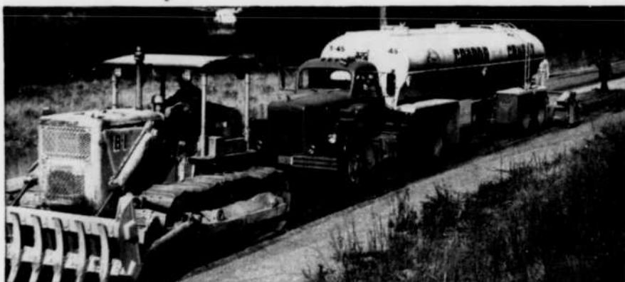
(A gauche) Dès que l'on a ameubli la chaussée, on répand le ciment. (A droite) Vue arrière du malaxeur et du camion-citerne; on remarque le mélange sol-ciment avant l'épandage.
