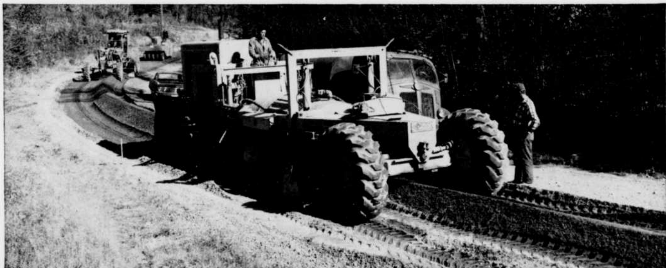
Avant les opérations d'épandage et de compactage, le malaxeur Pettibone mêle ensemble la terre, le ciment et l'eau.
