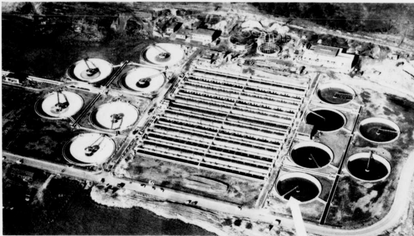
Vue aérienne d'une installation de traitement SIMPLEX avec schéma des bassins secondaires.
