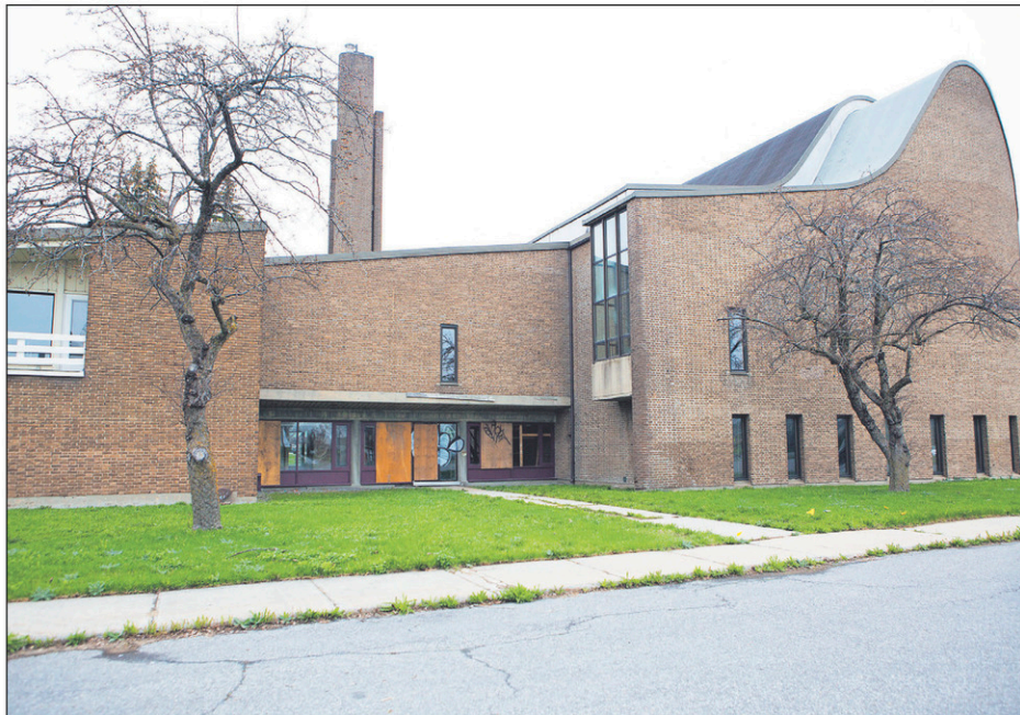
Les promoteurs du projet entourant la construction d'un complexe de 80 appartements assurent que l'église Saint-Gérard-Majella ne sera pas démolie.
