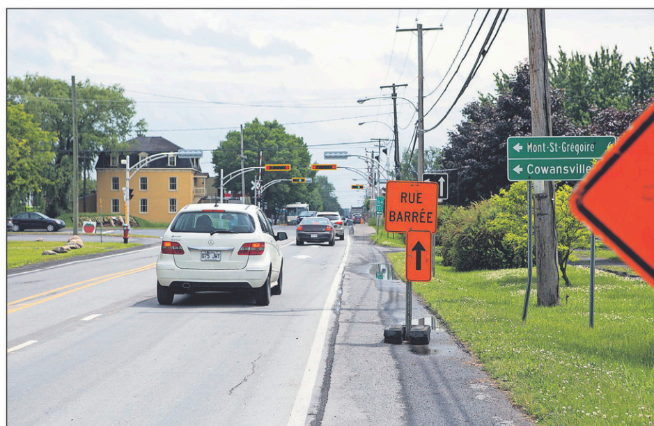
Les travaux sur le boulevard d'Iberville, entre la 7 e et la 9 e Avenue, sont en cours depuis lundi. Ils seront complétés le 13 juillet.
