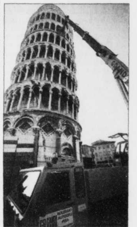
Une grue géante à l'œuvre sur la tour.
