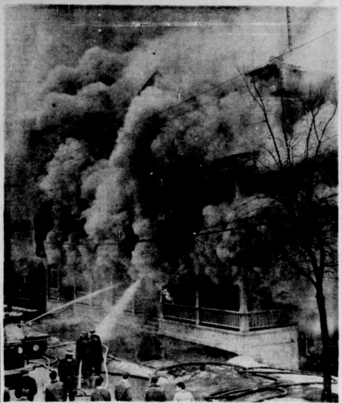
L'HOTEL VENDOME situé au 943, rue Cascade à Shawinigan a été complètement rasé par les flammes hier. Les dommages sont évalués à quelque $200,000.
